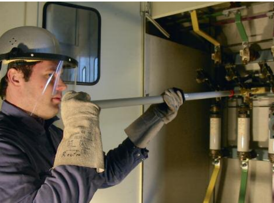
Arbeit unter Hochspannung
